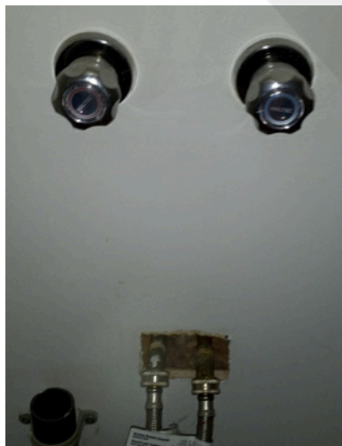
Valves du réservoir d'eau chaude
